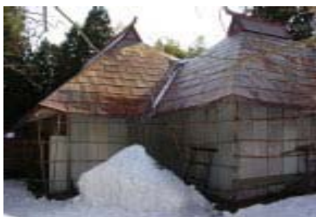
解体修理前の姿 平成 17 年 1 月
